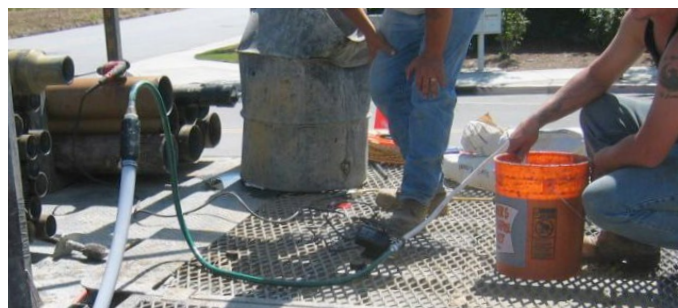
línea de lechada de 1" de diámetro conectada a Adaptador de lechada, fijado a la parte inferior del CMT.
