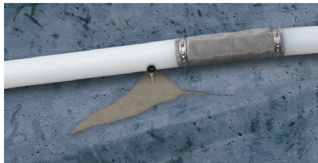
Lechada saliendo del tapón de lechada, debajo de la rejilla del puerto.
